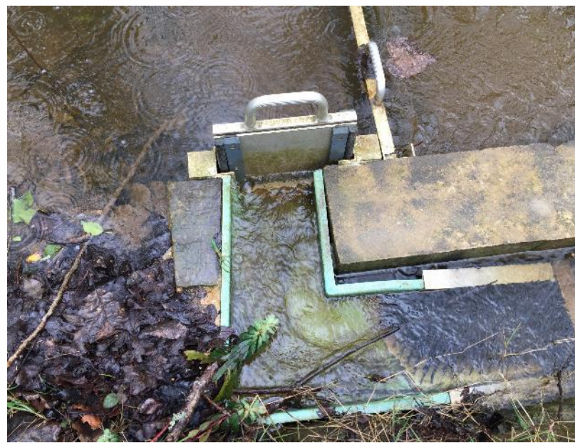
Prise d'eau des Grands Sables réaménagée (seuil, batardeau de réglage du débit réservé et passe à anguilles)
