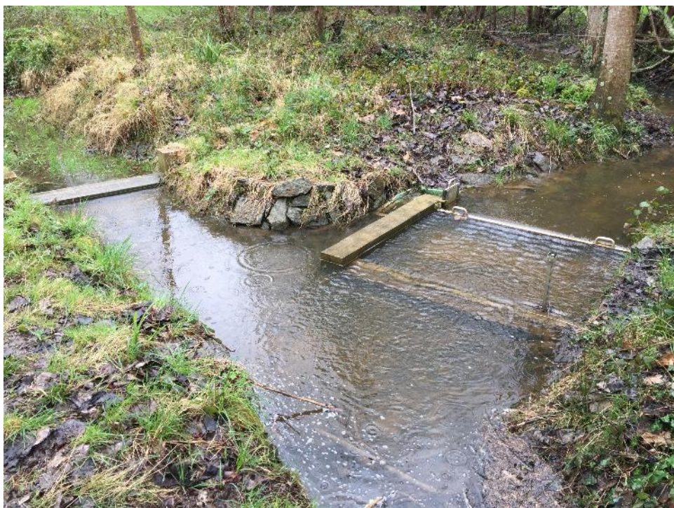
Prise d'eau des Grands Sables réaménagée (seuil, batardeau de réglage du débit réservé et passe à anguilles)
