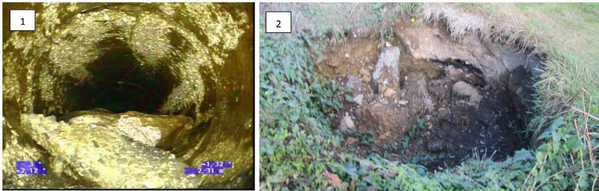
Photo 7: effondrements observés au niveau de la zone de Coat Conq à Concarneau (1 : effondrement de la canalisation, 2 : effondrement observé au niveau de la canalisation d'évacuation des eaux pluviales)
