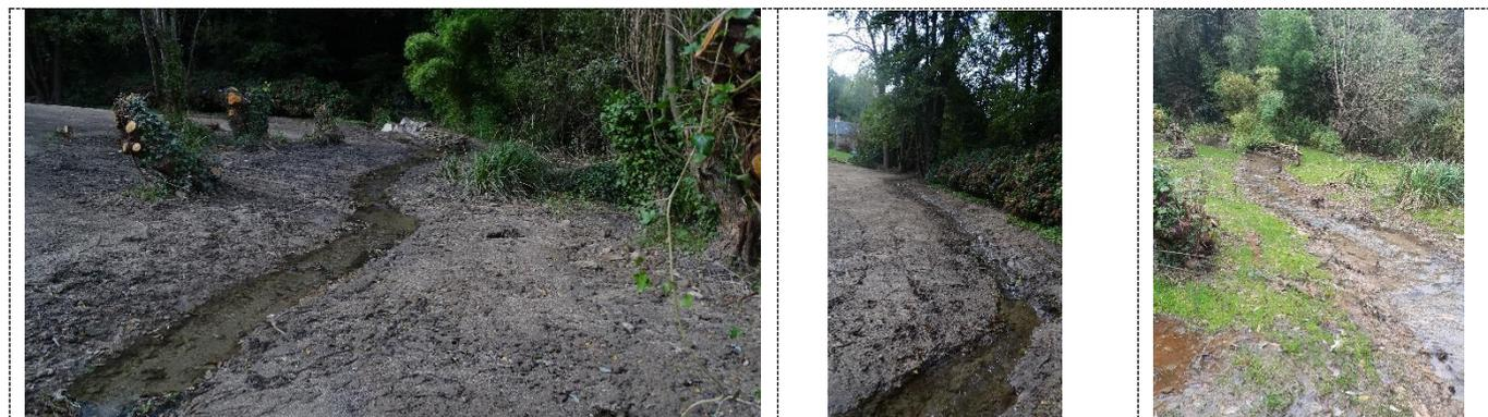
Remise à ciel ouvert du cours d'eau du Penfoullic sur 70 mètres à l'amont du plan d'eau de Hent Meil Choët supprimé en 2022 et finition des travaux sur les 150 mètres de tronçon aval remis à ciel ouvert.
