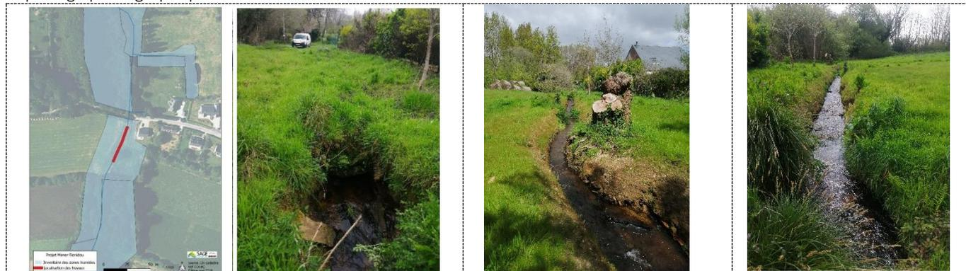
Remise à ciel ouvert du cours d'eau du Pontérec sur 40 mètres. Le reprofilage du cours d'eau non accepté par le propriétaire dans un premier temps sera rediscuter dans un second temps.
