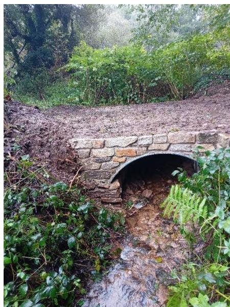
Sur le ruisseau de Kerlen, deux buses mal installées sur un ancien chemin agricole, ont provoqué une chute de plus d'un mètre. Les buses ont été enlevées. Aucun ouvrage n'a été installé. Les travaux sont suivis afin de voir si une érosion régressive ne va pas avoir lieu en amont, au niveau d'une buse sur la route départementale.
