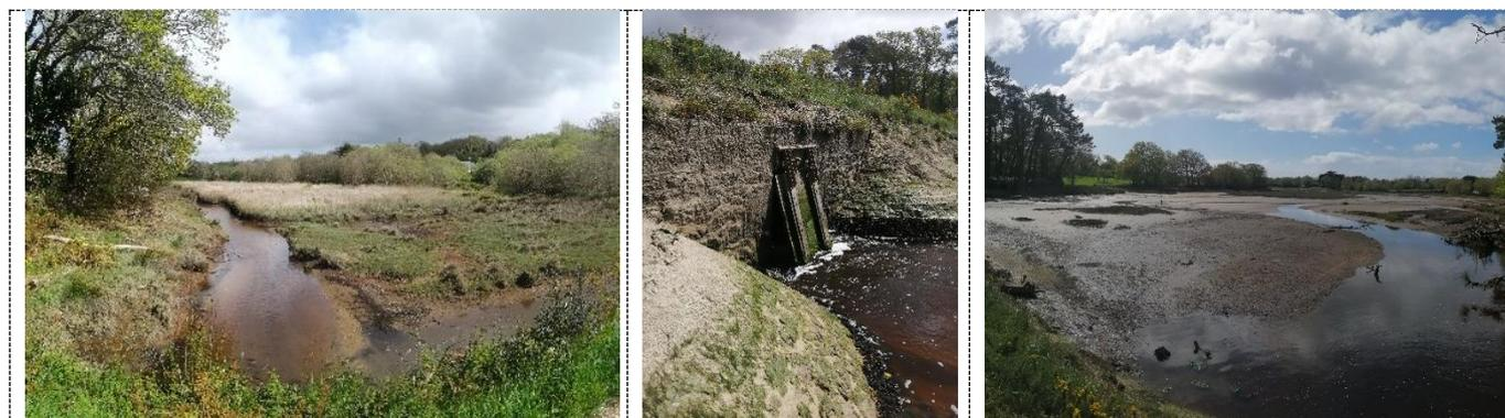
Mise en place d'une cale sur le clapet à marée du cours d'eau de l'anse du Petit Moulin pour favoriser la continuité avec réalisation de suivis de civelles, de suivi de végétation et de salinité. Photo 1 amont, photo 2 cale au niveau de la digue, photo 3 paysage aval.
