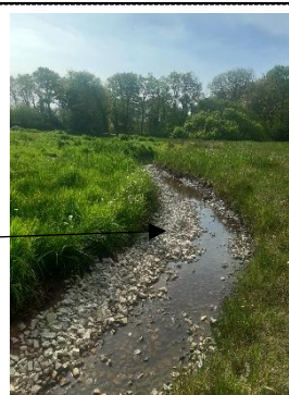
Restauration hydromorphologique par remise du cours d'eau du Henvez partielle dans la prairie de Carn Pont (DIG)
