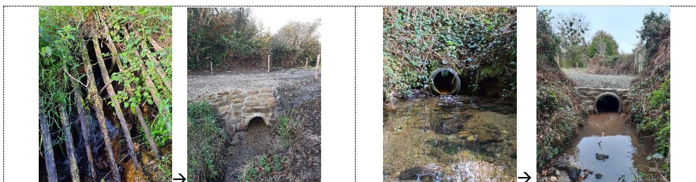
Retrait du seuil 152-MOU-MEZ (DIG) Pen Ilis Kerasploc'h et ouverture partielle petit cours d'eau de Beg Meil obstrué
