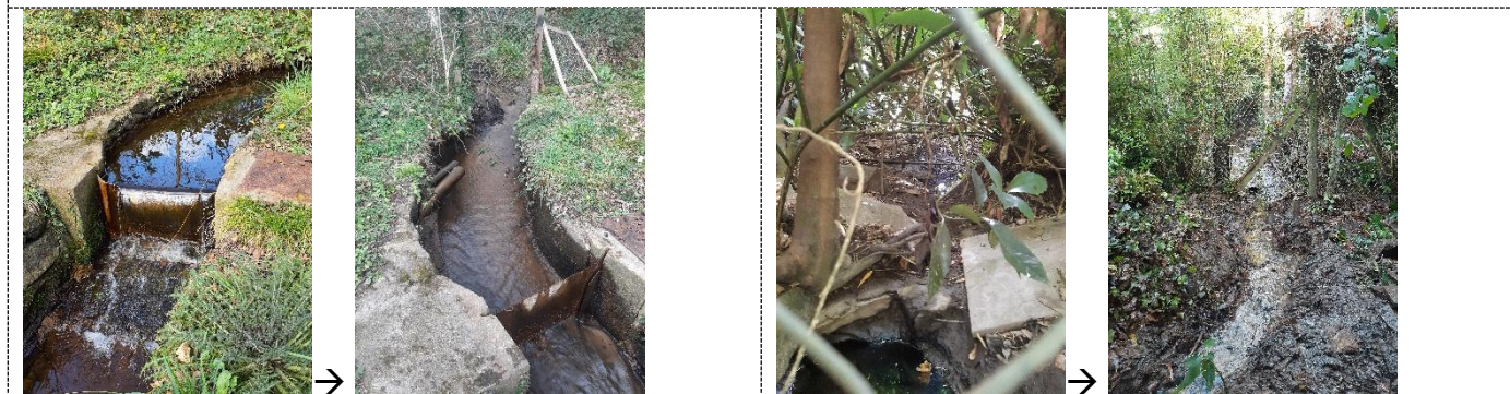
Retrait du seuil 152-MOU-MEZ (DIG) Pen Ilis Kerasploc'h et ouverture partielle petit cours d'eau de Beg Meil obstrué
